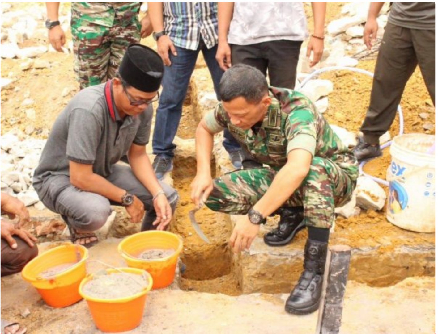
Dandim 0209/LB Letakan Batu Pertama Pembangunan Rumah Wartawan Mitra Binaan
